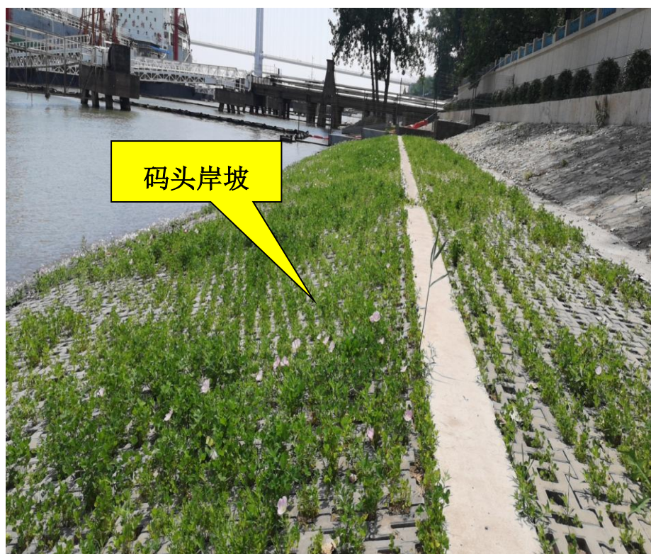
整治后 7#码头岸坡照片
