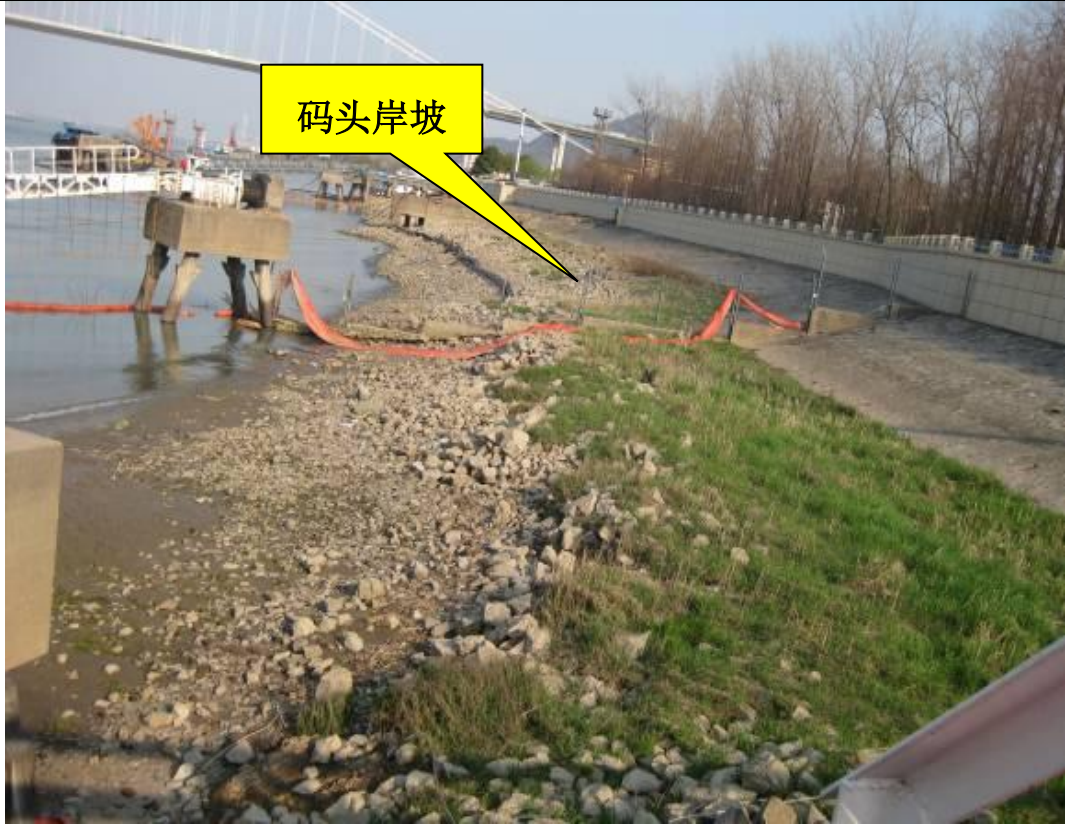
整治前 6#~8#码头岸坡照片
