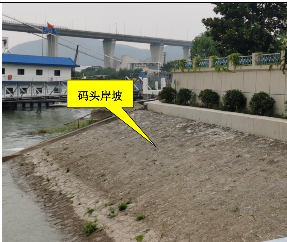
整治后 6#码头岸坡照片
