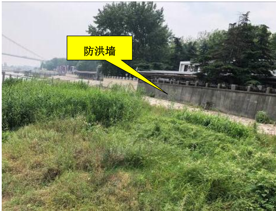
整治前 6#码头防洪墙照片
