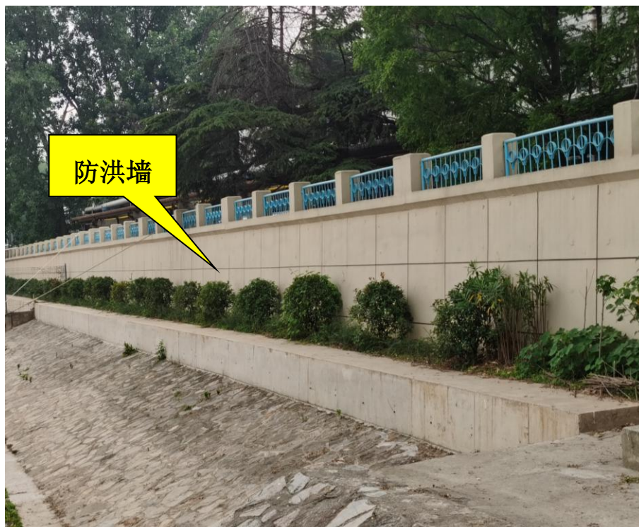
整治后 6#码头防洪墙照片
